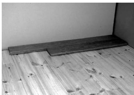
3. Husk at lægge plankerne i modsat retning end det eksisterende gulv.
