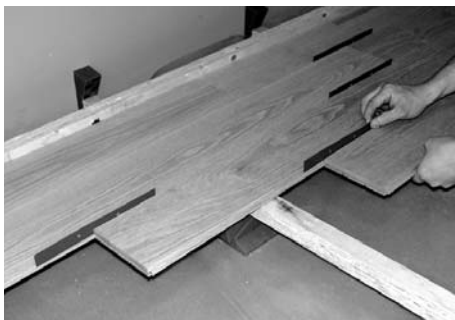
2. 10-brætsmål skal overholdes og der kan eventuelt anvendes spacers i 0,3 eller 0,6 mm tykkelse.
