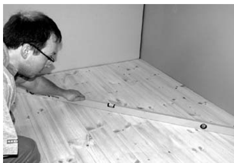
2. Bræddegulvet skal være plant +/- 2 mm pr. 2 m, målt med en retholt.
