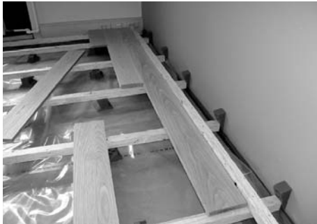
1. Du starter ved at lægge første planke mod en retholt.
