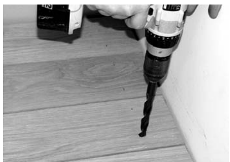
3. Ved montering af propper skal der forbores.
