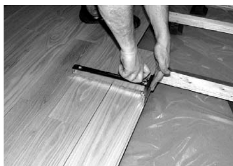
8. Anvend altid slagklods eller slagskinne. Ved planker der krummer kan det være nødvendigt, at kile plankerne på plads.
