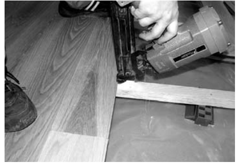
3. Hver planke sømmes eller skrues fordækt i fersiden i hver strø. Anvend 28x65 mm varmforzinkede runde dykkere ved håndsømning og 65 mm T-søm ved maskinsømning.
