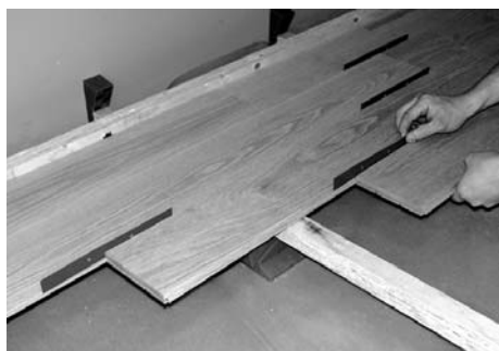
1. 10-bræts mål skal overholdes. Anvend eventuelt spacers i 0,3 eller 0,6 mm tykkelse.
