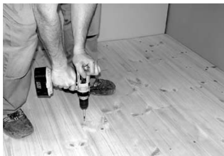
1. Bræddegulvet skal være stabilt, og uden knirkelyde. Om nødvendigt efterskrues.
