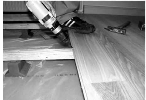
4. Ved skruning anvendes 4,2 x 55 mm Monta-Flex skruer, 1 stk pr. strø. Uanset om du sømmer eller skrues skal vinklen være 45 gr.
