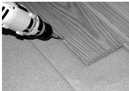
2. Hver planke skrues fordækt i fersiden pr. 50 cm. Ved skruring anvendes 4,2 x 35 mm Monta-Flex skrues med 45 gr. vinkel.
