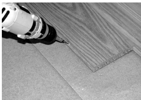
2. Hver planke skrues fordækt i fersiden pr. 50 cm. Ved skruring anvendes 4,2 x 35 mm Monta-Flex skruer med 45 gr. vinkel.
