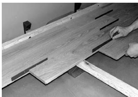
1. 10-bræts mål skal overholdes og der kan eventuelt anvendes spacers i 0,3 eller 0,6 mm tykkelse.
